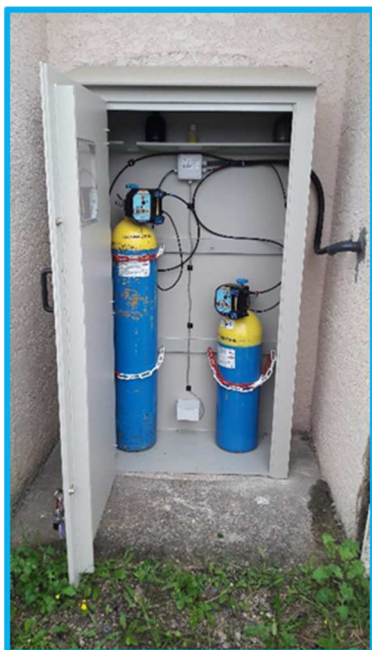
St Geniès des Mourques - Bérange : Armoire Chlore Gazeux
